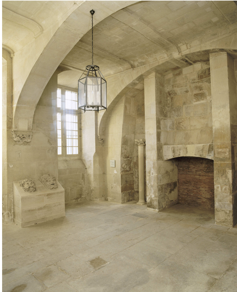
Description : Appartement des bains Emplacement dans le château : sous-sol du château
